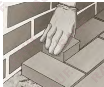
Укладка очередных рядов клинкерной брусчатки.
