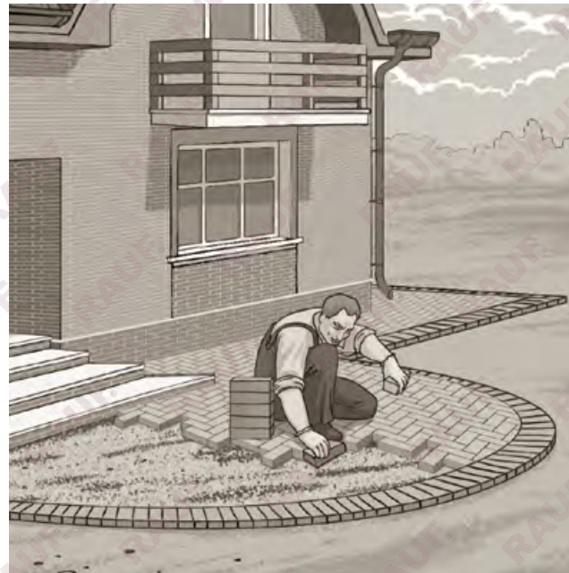
Укладка очередных рядов клинкерной брусчатки.
