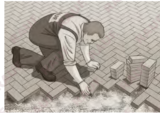
Мощение поверхности с формированием узора «елочка».
